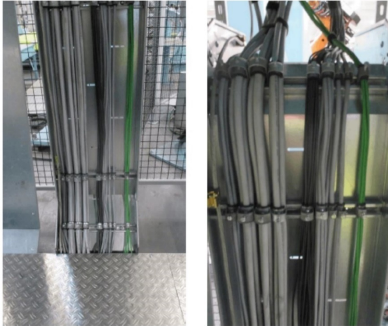
Bild 5: Vertikale Kabeltrassen
